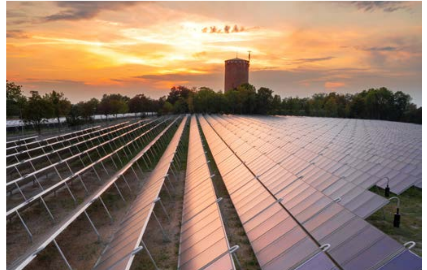
Planta fotovoltaica para alimentar la estación generatriz de energía de un distrito
